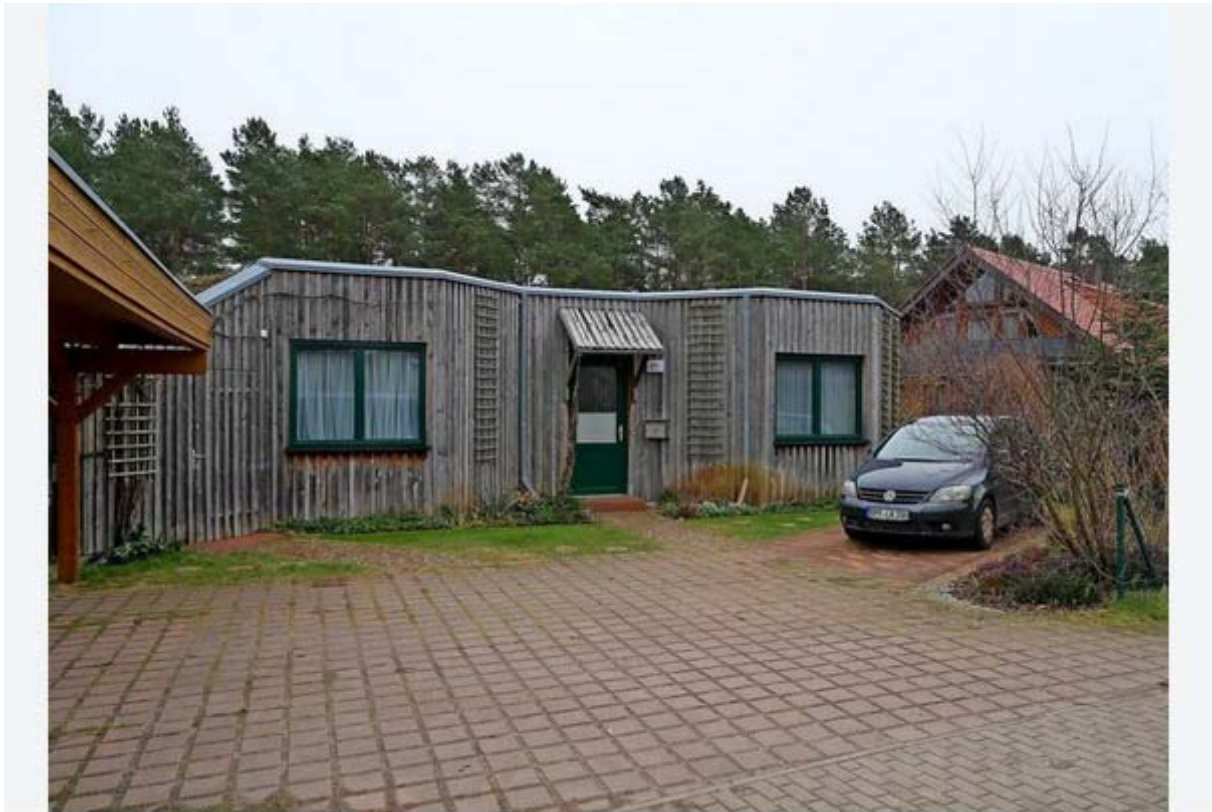
Im neuen Jahrtausend hat die Rewoge auch auf Ökohausbau gesetzt. Die neuen Häuser tragen den Namen Oikos. Quelle: Henry Mundt
