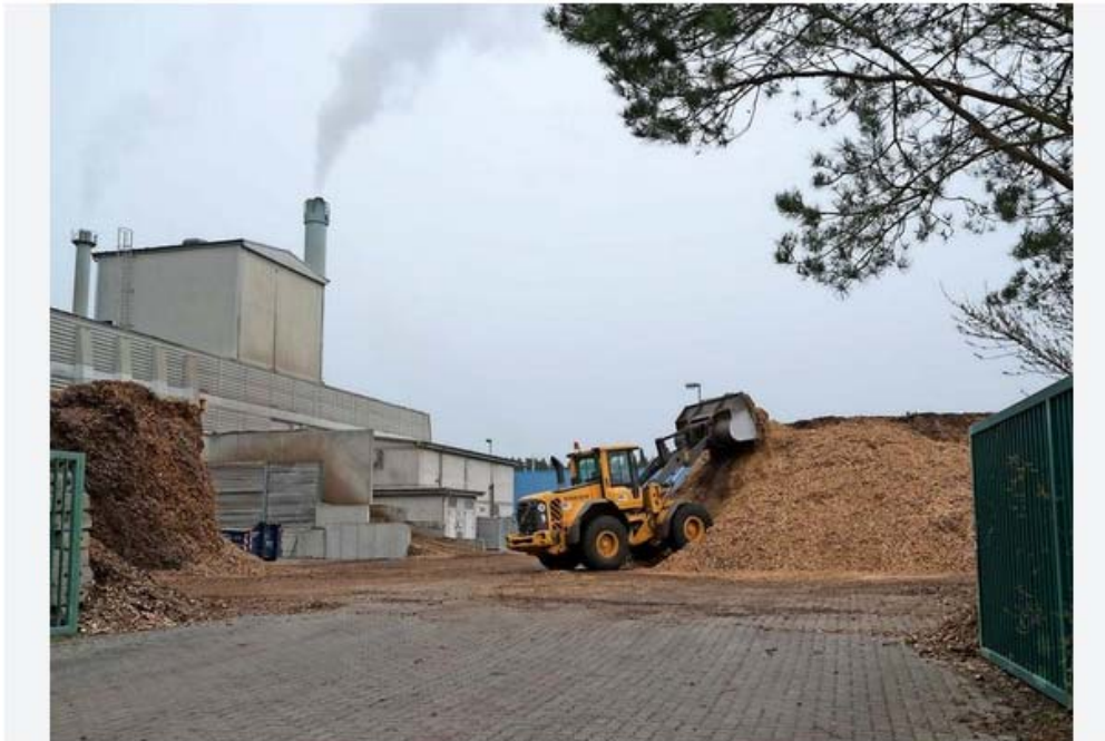
Das Blockheizwerk der Rheinsberger Stadtwerke sorgt seit den 1990er Jahren für einen minimalen Kohlendioxidausstoß in der Stadt. Quelle: Henry Mundt
